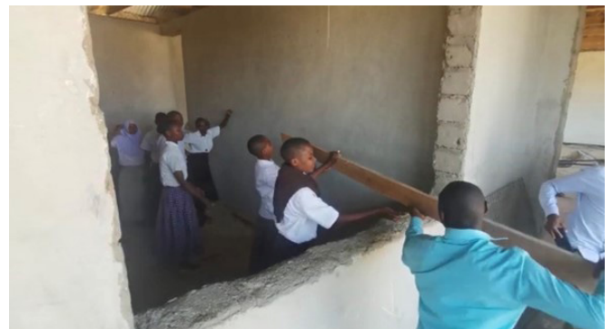
Die Kinder helfen mit, das Gebäude für die SuMeWa-Anlage zu bauen.
