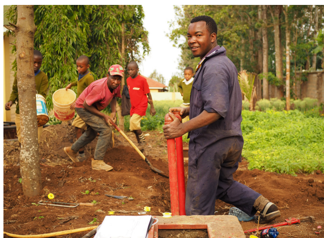
Hassani installiert den Wasserzähler zur Durchflussüberwachung.
