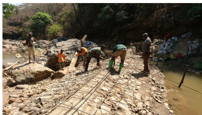
Die mit Armierungen verstärkte Dammkrone.
